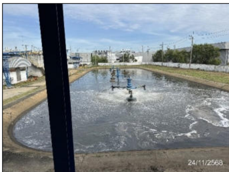
ภาพที่ 2.2-2 ระบบบำบัดน้ำเสียส่วนกลาง
